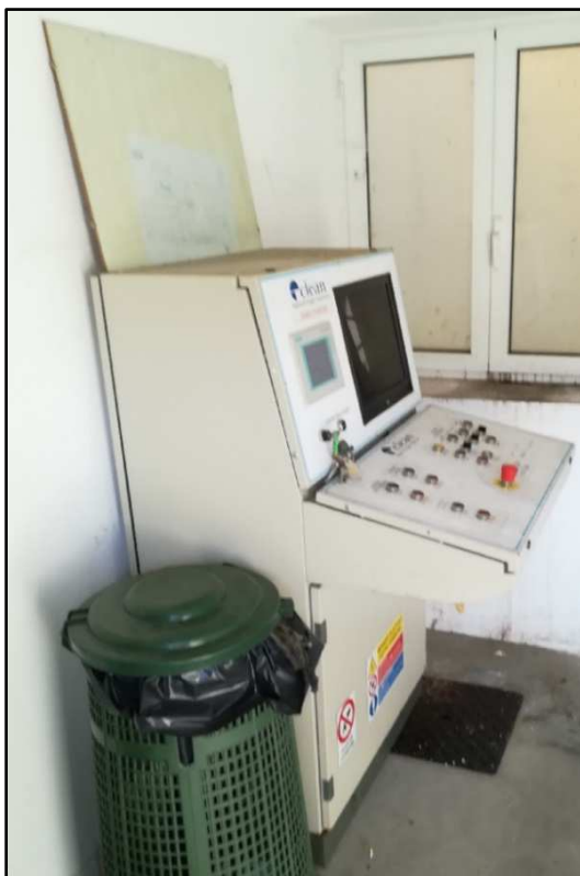
Foto 2 – Quadro elettrico carro lavaggio mezzi a ponte
